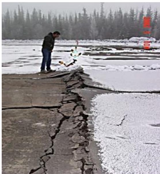
Рис. 2.18. Разрушение взлетной полосы аэродрома Northway Airport (Alaska, USA), 2002
