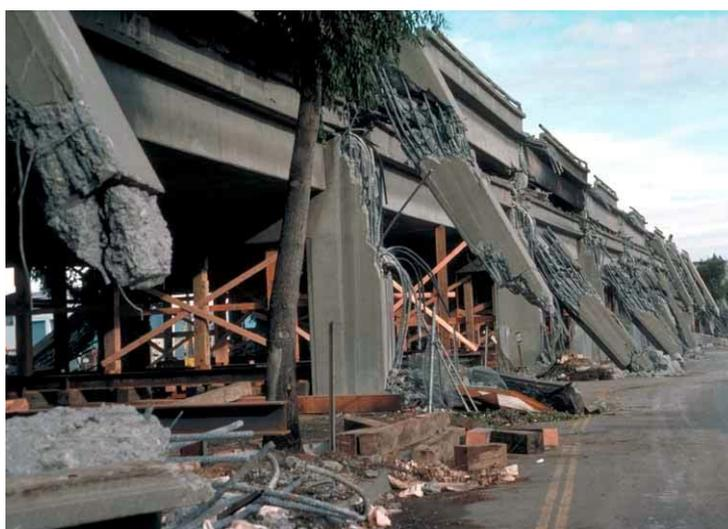
Рис. 2.19. Разрушение, связанное с нерасчетным изгибом колонн виадукса в Сан-Франциско. Разрушения вызваны приходом волн Рэлея – Лэмба от землетрясения интенсивностью 6.9 балла, произошедшего в октябре 1989 г. в Северной Калифорнии (Лома-Приета)
